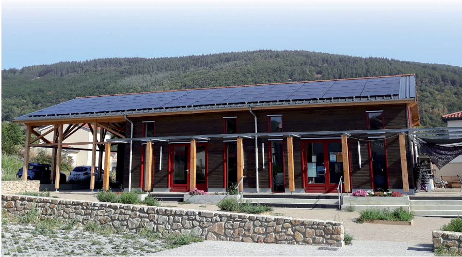
Mise en service sur un bâtiment communal à Chuyer de la 12 ème installation photovoltaïque de la CVRC
