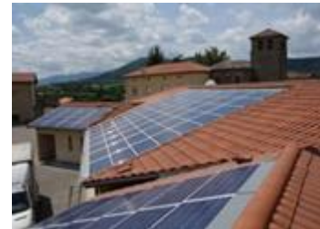
Installations sur le toit de la mairie et de la salle polyvalente
